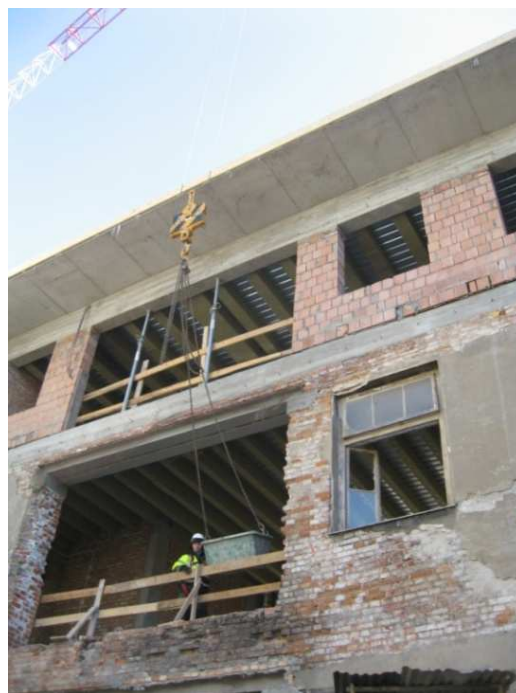
Rys. 8. Usytuowanie zblocza w momencie zerwania liny Fig. 8. Pulley block position at the instant of rope failure
